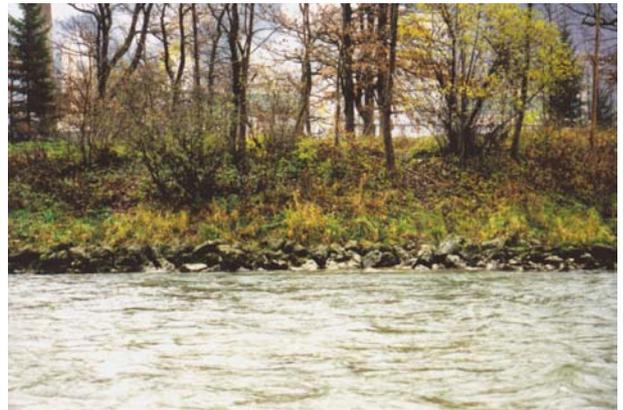
Abb. 57. Ufer rechts, Blockwurf
