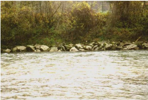
Abb. 40. rechte Uferböschung, Blockwurf
