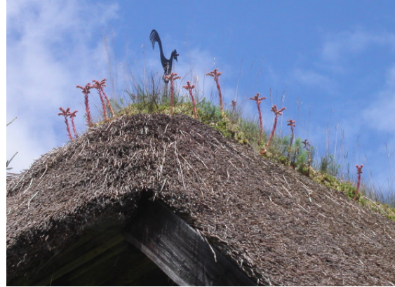
„Donnerwurz“ als Blitzableiter an einem „Troadkasten“ in St. Veit/M.; 8.8.2005
