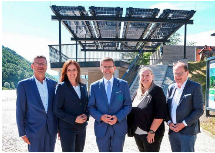
Das neue Schiffsinfrastrukturgebäude wurde vom Gebäude- und Beschaffungsmanagement des Landes OÖ mit einem Investitionsvolumen von 450.000 Euro errich-
