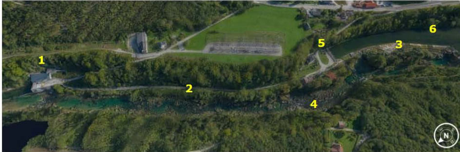
Bild 6: Bestand KW Traunfall: Wehranlage (3) - Einlaufbauwerk (5) - Druckkanal (2) - Krafthaus (1) – Restwasserstrecke Traunschlucht (4) (Quelle: Projektunterlagen)
