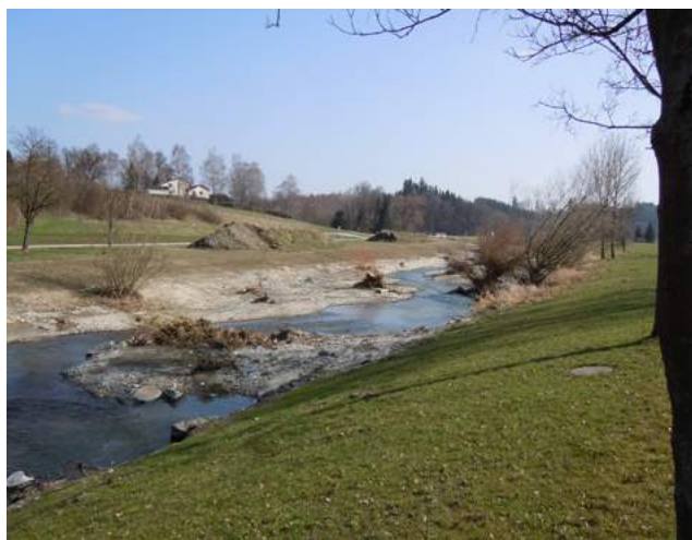
Renaturierte Gewässerstrecke an der Pram kurz nach Fertigstellung
