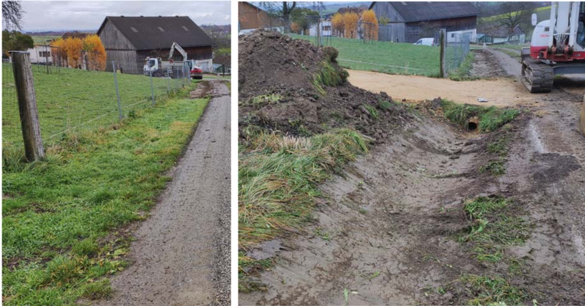
Abb. 29 Straßengraben neben dem Entengehege vor der Maßnahme (links); Verrohrung der Feldausfahrt und der Straßengraben nach Fertigstellung(rechts).
