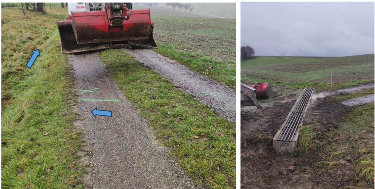
Abb. 18 Gemeindestraße vor Einbau des Rigols und zukünftiger Fließweg (blaue Pfeile) (links); Rigol nach Fertigstellung.
