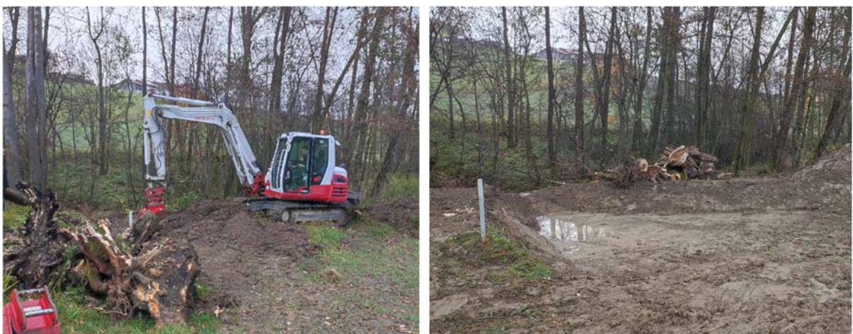
Abb. 21 Erdarbeiten beim Muldenbau (links); Mulde nach Fertigstellung (rechts).
