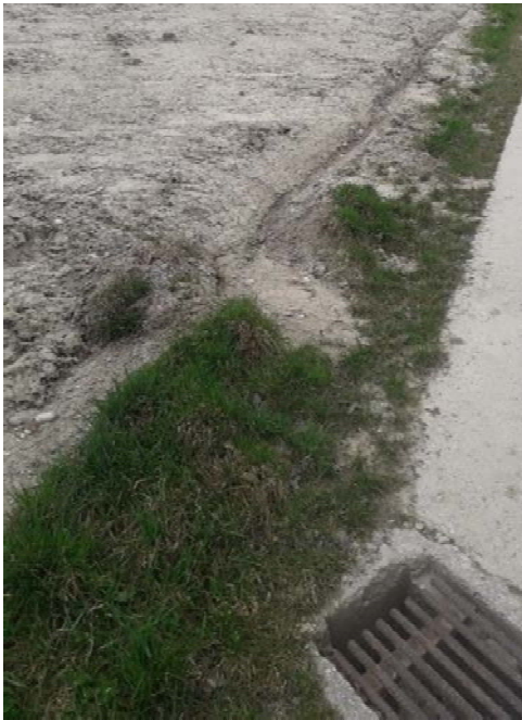
Abb. 17 Temporäre Lösung im März 2023: manuelle Umleitung des Wassers in das bestehende Rigol (welches das Wasser in eine breite, begrünte Abflussmulde leitet)
