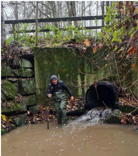
Abb. 37 Vorortbegehung und Standortsuche am Messenbach im November 2023. Zu sehen ist der zuerst präferierte aber dann verworfene Standort, da es keine Zustimmung der Grundstückseigentümer gab.
