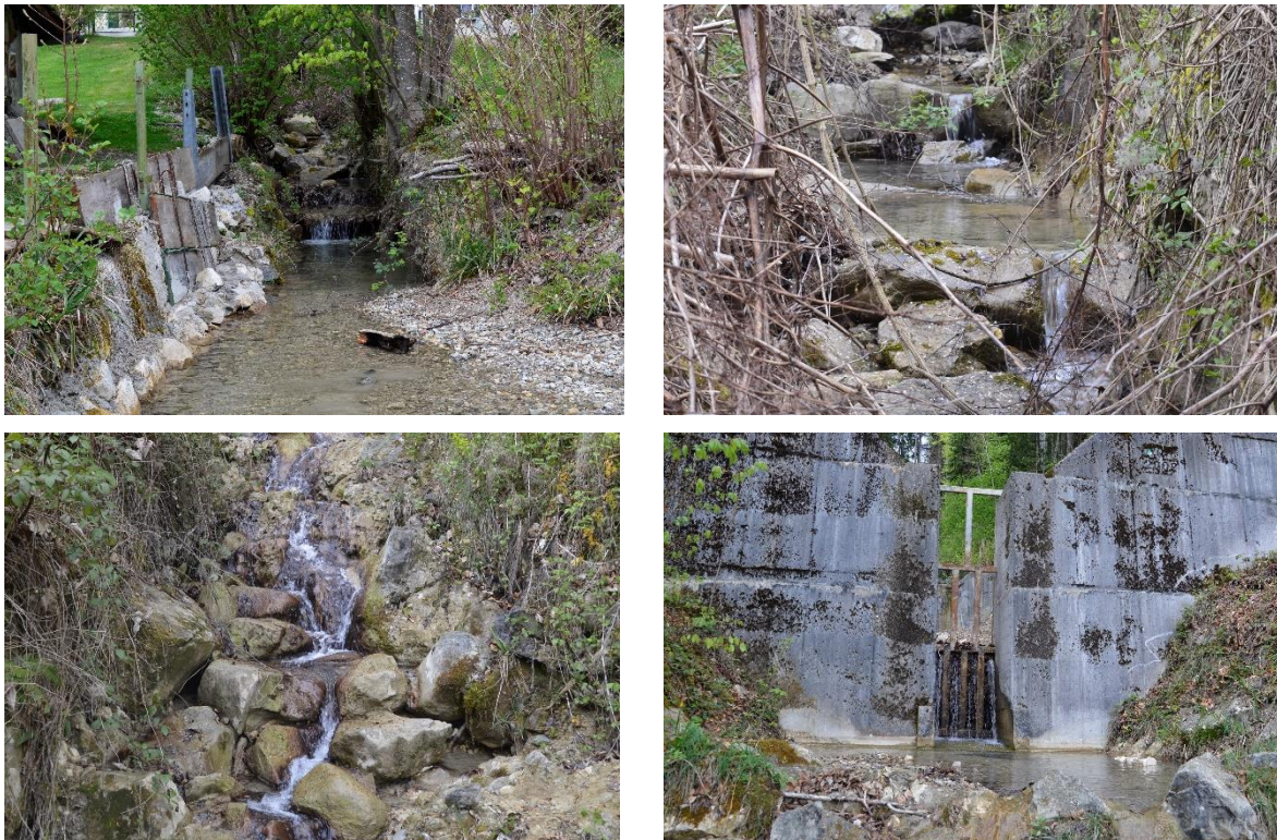
Abbildung 22: Links oben: Segment 1, Mündungsbereich mit rechtsufriger Uferverbauung, beidseitigen Begleitgehölzen und einer hölzernen Sohlschwelle ( \Delta h 30 cm) – nicht fischpassierbar; rechts oben Segment 2, Unterer Bereich mit zwei künstlichen
