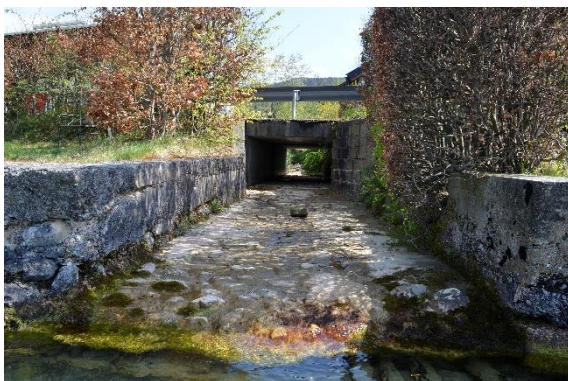
Abbildung 33: Links oben: Segment 1, Unterer Bereich mit trockengefallenem Schwemmkegel des Großen Dirnbachs; rechts oben Segment 1 Verblocktes und ausbetoniertes Bachbett mit beiderseitiger Ufermauer des Großen Dirnbachs – kein Wasser; links unten: Segment 1, Trockengefallener völlig ausbetonierter Mündungsbereich des Kleinen Dirnbachs – kein Wasser; rechts unten: Segment 1, Trockengefallenes Bachbett mit linksufriger Ufermauer.
