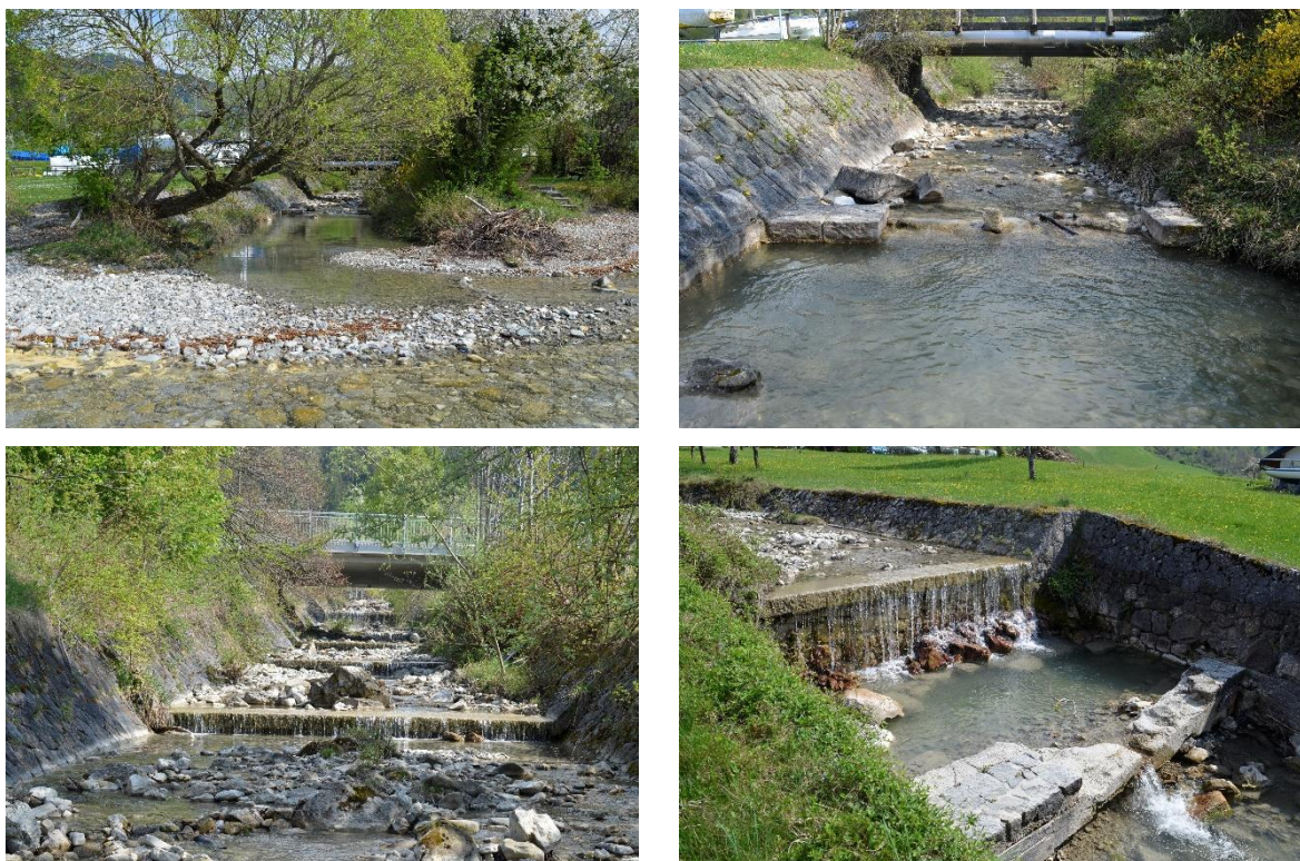
Abbildung 37: Links oben: Segment 1, Mündungsbereich mit Idealsubstrat und Schwemmkegel; rechts oben Segment 2 Unterer Bereich mit beidseitiger Ufermauer, grobem Substrat und Steinschwelle -fischpassierbar; links unten: Segment 2, Mittlerer Bereich, Stark begradigter Bereich mit beidseitiger Ufermauer, grobem Substrat und einer Abfolge von Sohlschwellen – nicht fischpassierbar; rechts unten: Ende Segment 3, Oberer Bereich, Zwei hohe Sohlschwellen (bis zu \Delta h 60 cm) – nicht fischpassierbar und beidseitiger Ufersicherung.
