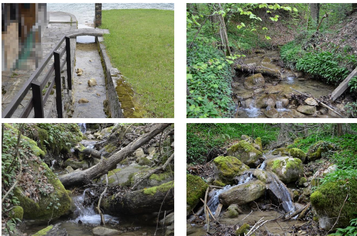
Abbildung 24: Links oben: Segment 1, Begradigter Mündungsbereich mit Uferverbauung ; rechts oben Segment 2 Unterer Bereich mit natürlicher Substratzusammensetzung im Wald; links unten: Segment 2, Mittlerer Bereich, Steilerer Abschnitt mit hohem Totholzanteil und natürlicher Substratzusammensetzung im Wald; rechts unten: Ende Segment 2, Oberster Bereich, Natürliche stark versinterter Schwellen ( \Delta h 130 cm) - nicht fischpassierbar im Wald.
