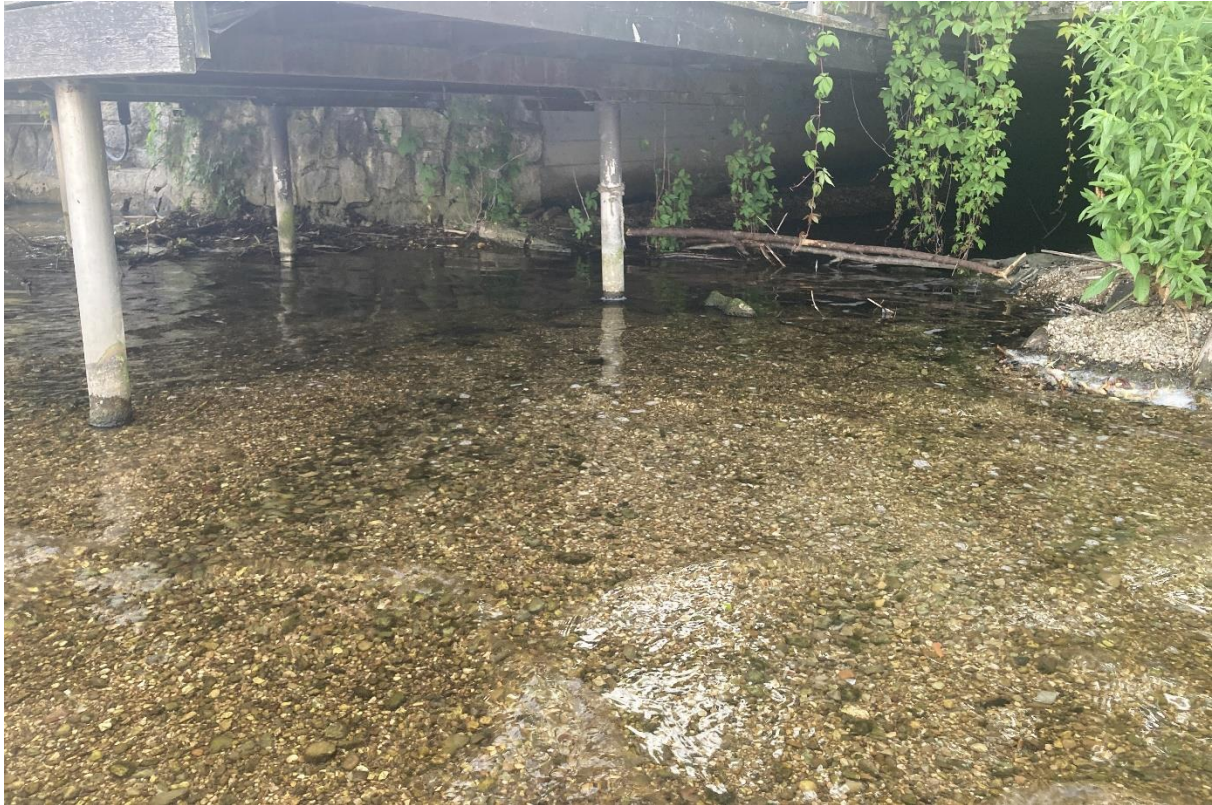
Abbildung 48: Abbildung des Bereichs Gerlhamerbach Schwemmkegel.
