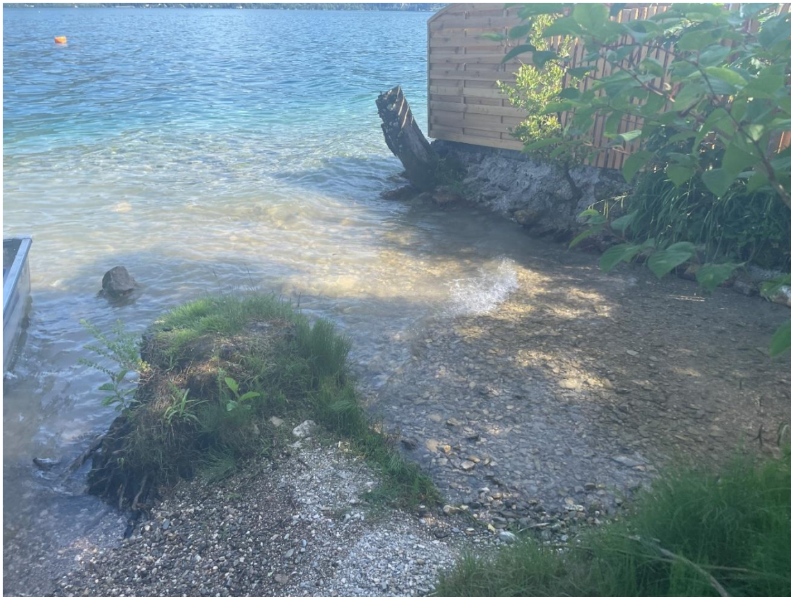
Abbildung 146: Bild des Bereichs Kolmbauernbach Schwemmkegel.
