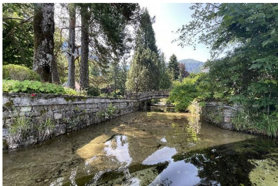
Abbildung 28: Links oben: Segment 1, Unterster gepflasterter Bereich mit Querbauwerk am Ende ( \Delta h 40 cm) nicht fischpassierbar;
