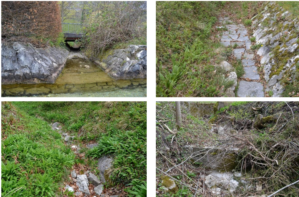
Abbildung 30: Links oben: Segment 1, Gepflasterte Mündung ohne erkennbaren Schwemmkegel - kein Wasser; rechts oben Segment 2 Mit Bärlauch bewachsenes gepflastertes Bachbett – kein Wasser; links unten: Segment 3, Mit Bärlauch bewachsenes Bachbett mit großem Substrat - kein Wasser; rechts unten: Segment 4, Oberer Bereich, Trockenes Bachbett mit Schnitgut und betonierter Sohlschwelle ( \Delta h 40 cm) – nicht passierbar.
