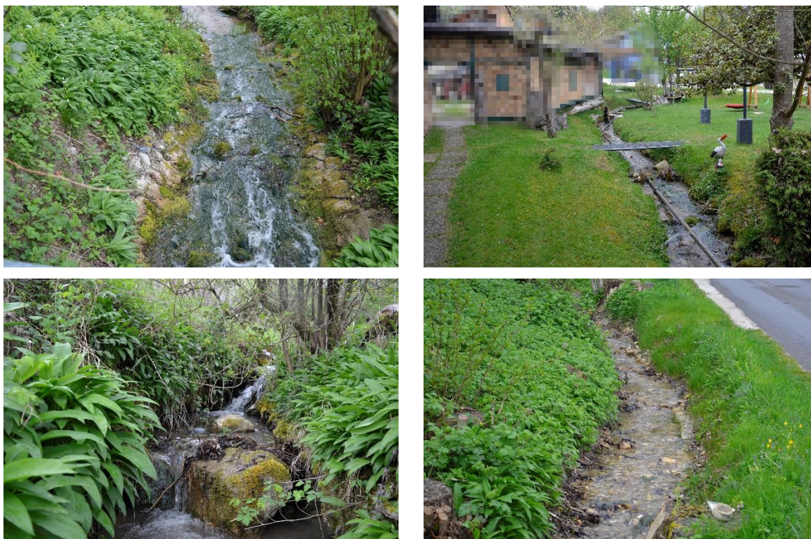
Abbildung: Links oben: Segment 1, Blickrichtung bachabwärts, Unterer Bereich, Gepflasterte/betonierte Sohle mit steilem Gefälle – nicht fischpassierbar; rechts oben Segment 2 Begradigter Bach im Privatgarten mit Wasserspielereien (Ausleitung, Wasserrad); links unten: Segment 3, Mittlerer Bereich, Natürliche Schwellen (Steine, Δh 50 cm) – nicht fischpassierbar mit dichter Ufervegetation; rechts unten: Segment 4, Oberer Bereich, Ausgeräumter Graben neben der Straße mit wenig Wasser.
