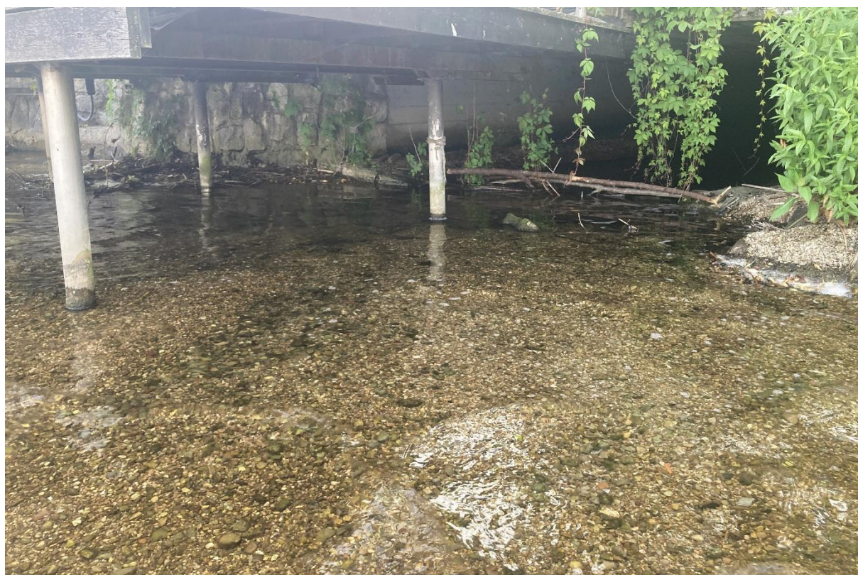
Abbildung 88: Abbildung des Bereichs Gerlhamerbach Schwemmkegel.
