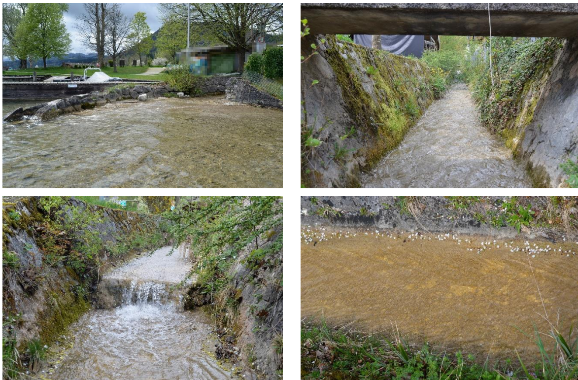
Abbildung 16: Links oben: Segment 1, Mündungsbereich mit gepflasterter/betonierter Mündung; rechts oben Segment 1 Unterer Bereich mit begradigtem betoniertem V-Profil; links unten: Segment 1 Oberer Bereich, Betonierter Sohlabsturz ( \Delta h 30 cm) – nicht fischpassierbar; rechts unten: Ende Segment 1, Oberer Bereich, Detailaufnahme der betonierten Sohle mit dünner Wasserlamelle.
