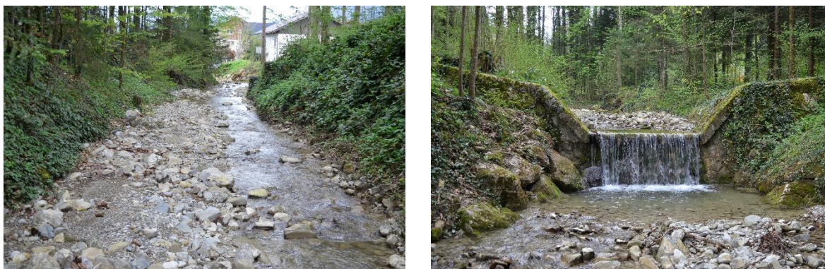
Abbildung 20: Links oben: Segment 1, Mündung und unterster gepflasterter Bereich (U-Profil); rechts oben Ende Segment 1: Betonierte Sohlrampe (Rutsche; \Delta h 150 cm) – erschwert fischpassierbar; links unten: Segment 3, Blickrichtung bachabwärts Oberer Bereich, Naturnahe Morphologie mit natürlicher Substratzusammensetzung im Wald; rechts unten: Ende Segment 4, Oberster Bereich, Sohlschwelle mit Gumpen ( \Delta h 140 cm) – nicht passierbar umgeben von Wald.
