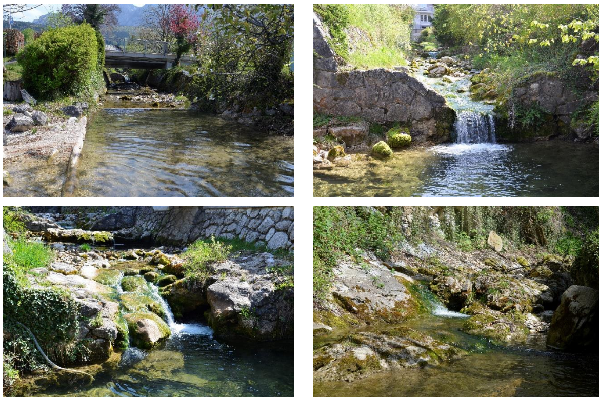
Abbildung 34: Links oben: Segment 1, Unterster Bereich, Begradigter Mündungsbereich mit leicht fischpassierbarer Holzschwelle; rechts oben Segment 1 Oberer Bereich mit betonierter Steinschwelle ( \Delta h 50 cm) – nicht fischpassierbar; links unten: Segment 2, Mittlerer Bereich, Private Wasserentnahme neben teilweise aufgelöster Schwelle ( \Delta h 50 cm) – erschwert fischpassierbar; rechts unten: Ende Segment 3, Natürliches Bachbett mit grobem Substrat.
