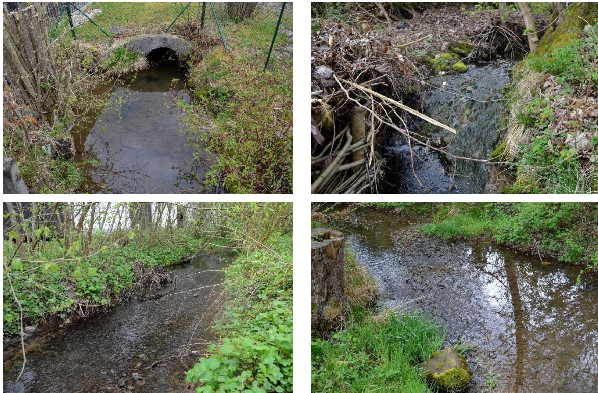
Abbildung 14: Links oben: Segment 1, Ende des untersten verrohrten Bereichs; rechts oben Segment 3 Mittlerer Bereich mit versinterter Sohlschwelle, ( \Delta h 45 cm) – erschwert fischpassierbar; links unten: Segment 5, Mittlerer Bereich, Bachlauf mit naturnaher Morphologie und natürlicher Substratzusammensetzung gesäumt von Ufergehölzen; rechts unten: Segment 6, Oberer Bereich, Naturnahe Furt mit natürlicher Substratzusammensetzung.
