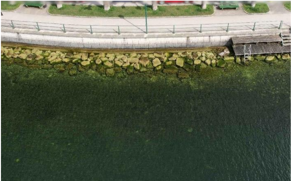
Abb. 6: Mauer mit Blockwurf-Vorschüttung.
