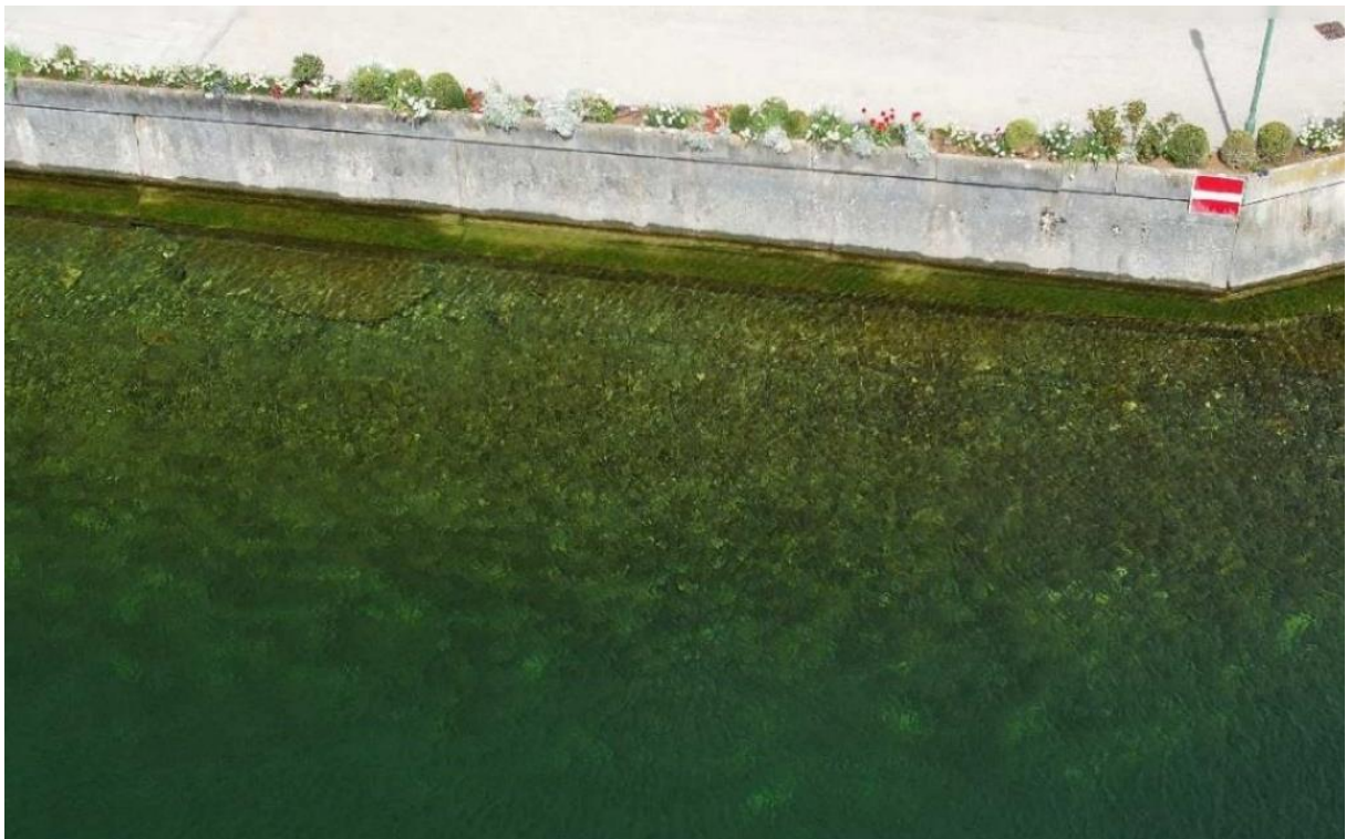
Abb. 5: Betonmauer / Steinmauer, verfugt.
