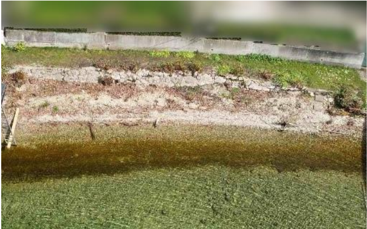
Abb. 14: Verbau nur oberhalb Mittelwasser.
