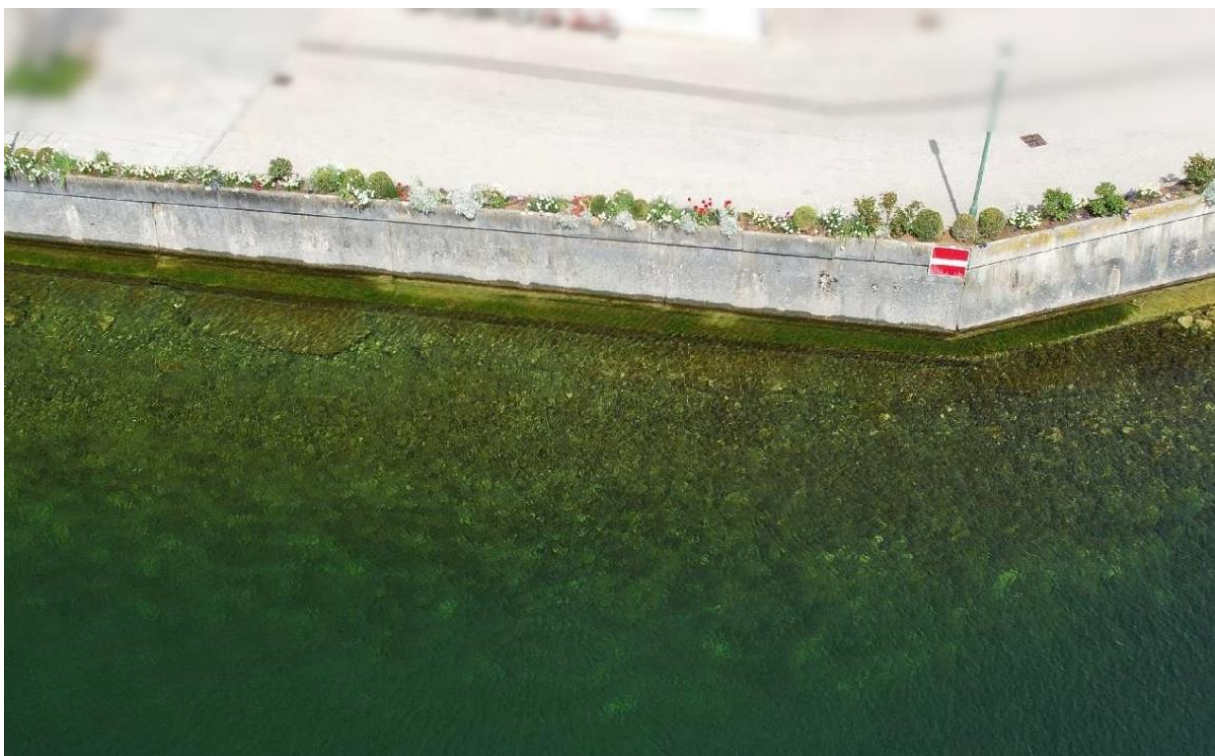
Abb. 5: Betonmauer / Steinmauer, verfugt.
