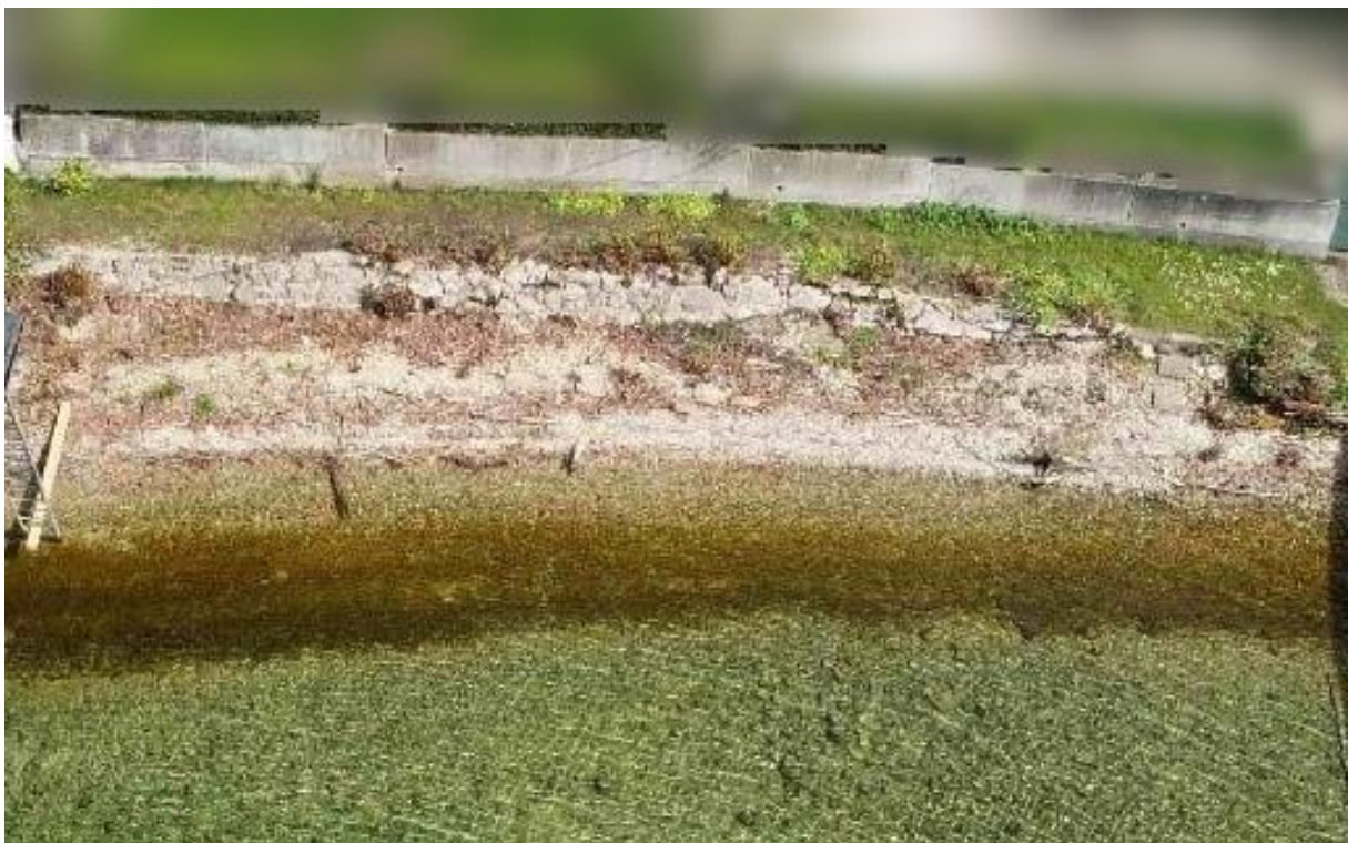
Abb. 13: Verbau nur oberhalb Mittelwasser.
