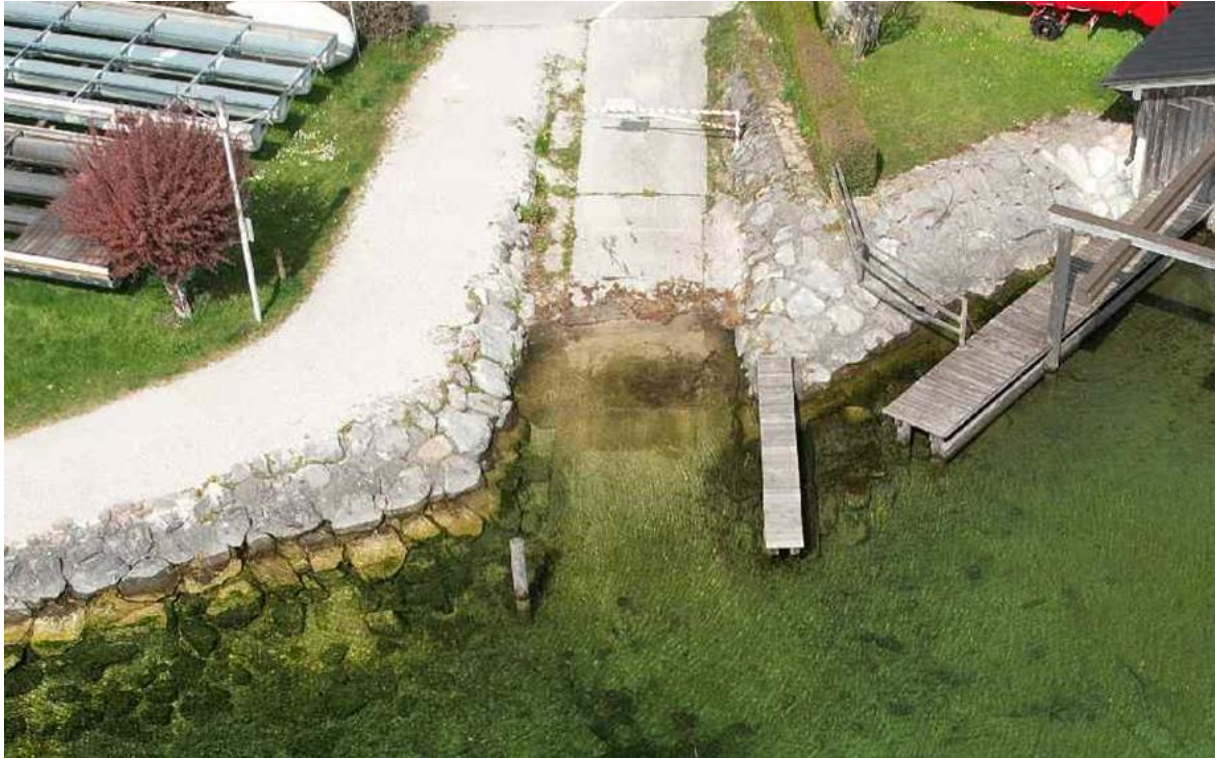
Abb. 4: Betonierte Rampe.
