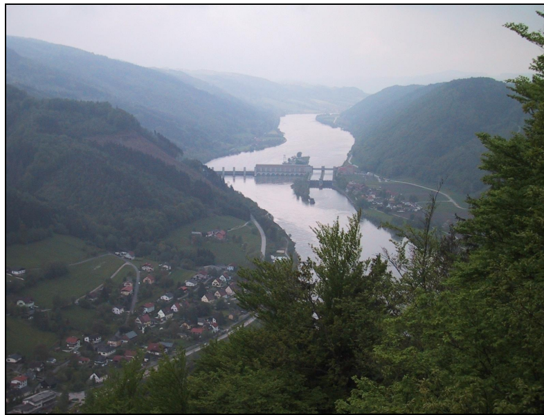
Abb. 2.3 Kraftwerk Jochenstein flussaufwärts von Engelhartzell
