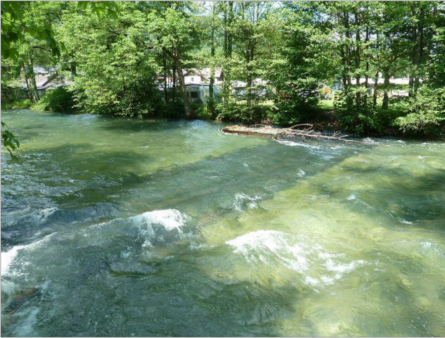
Abb. 20 Überströmung des dynamischen Fischwehres durch das Hochwasser in der Seeache Anfang Juni 2010.
