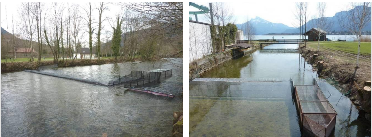
Abb. 9 Dynamisches Fischwehr mit integriertem Reusenkasten zum Fang stromaufwärts wandernder Fische in der Seeache (links) und in der Zeller Ache (rechts).
