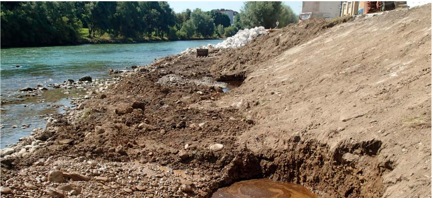
Sanierung der Altlast O85 Ölverunreinigung Ennskai - Quelle: GUT Gruppe Wasser und Technik GmbH
