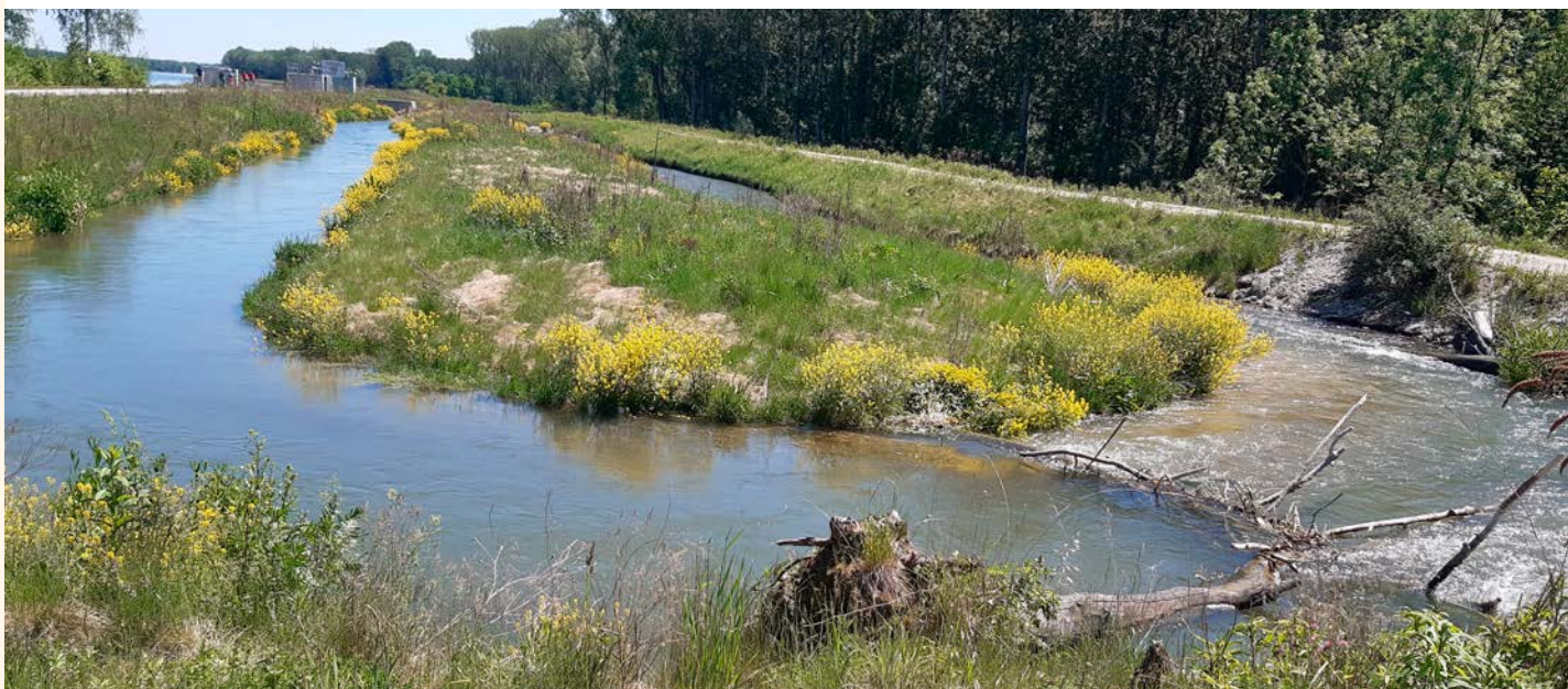
Fischaufstieg Kraftwerk Abwinden/Asten - Quelle: ©Mag. Gunter Labner (AUWR)
